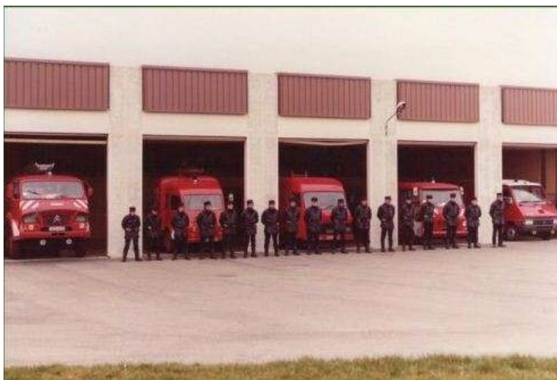
Construite sur un terrain communal situé rue Henri Réaux, cette caserne d'une superficie de 600m 2 peut accueillir de nombreux stagiaires en formations diverses.
